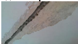
Ремонт шва между плитами перекрытия
